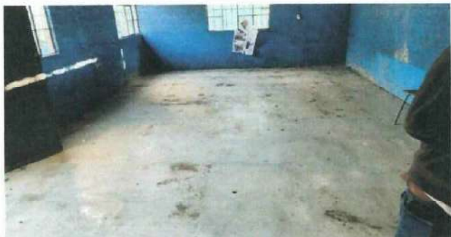
Foto 7: Mejoramiento de losa de patio a piso cerámico en aula 1
