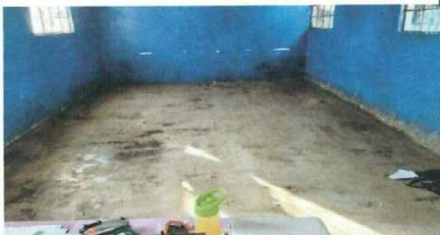
Foto 9: Mejoramiento de losa de patio a piso cerámico en aula 2
