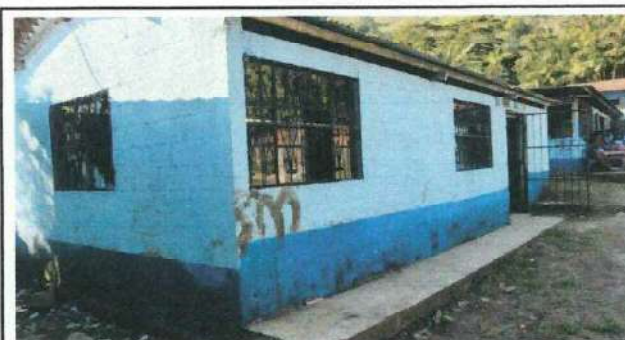
Foto 6: Repello de paredes de aula 1, exterior
