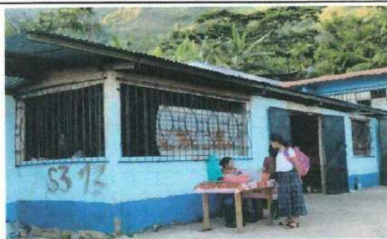
Foto 4: Repello de paredes de cocina, exterior
