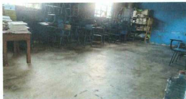
Foto 10: Mejoramiento de losa de patio a piso cerámico en aula 3
