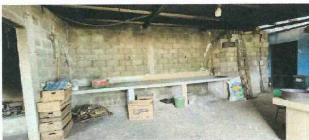
Foto 2: Mantenimiento a estructura del techo de la cocina
