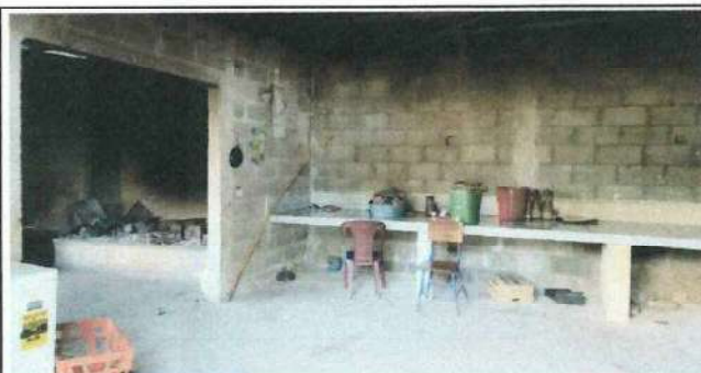
Foto 3: Repello de paredes de cocina interior
