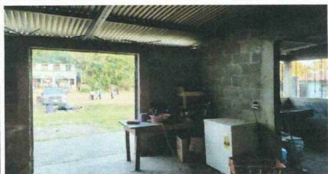
Foto1: Levantado de techo de la cocina
